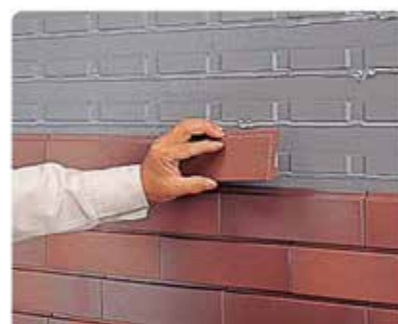
[引っ掛けて張るベルパーチ工法]
