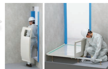
【2分割構造でリフォームしやすい】 浴槽とエプロン付洗い場をそれぞれ運べるので搬入性が大幅向上。狭い間口でも搬入可能に。作業スペースを広く使えるので、ボルト脚調整や排水管取付が作業しやすい。
