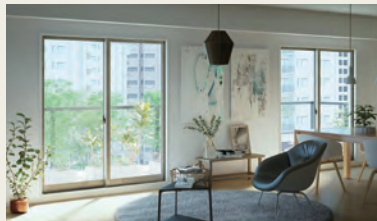
窓の断熱リフォーム 「内窓」設置
