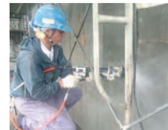
超高压水洗目荒らし工事
