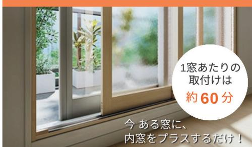
今ある窓と内窓「インプラス」の間にできる 空気の層が断熱材に！
